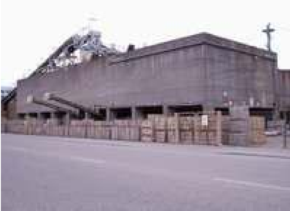
Gambar 4.6. Silo berbentuk kotak
